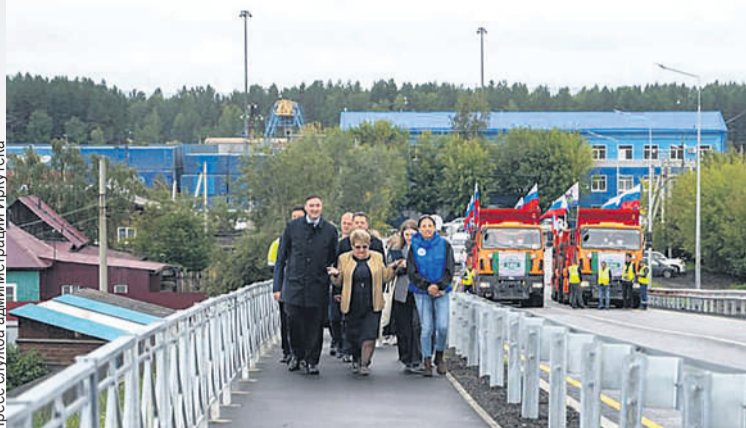
Открытие долгожданного путепровода на станции Батарейная.
